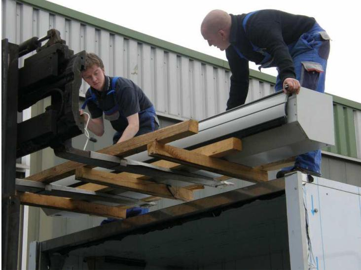
2. Il faut maintenant introduire les lamelles du volet roulant dans les rails de guidage latéraux de l'EWK. Pour ce faire, il faut basculer avec précaution le caisson de volet roulant d'environ 80° et introduire les lamelles du volet roulant dans les rails de guidage.
