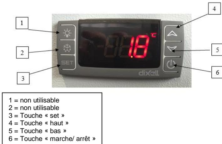
L'eau contenue dans l'armoire de choc est maintenue dans une certaine plage de température. La température de l'eau est mesurée par une sonde de température. Si la température de l'eau dépasse une valeur préalablement définie, le groupe d'eau glacée démarre. L'eau est alors refroidie. Dès que la température de l'eau atteint une valeur limite inférieure, le groupe d'eau glacée s'arrête à nouveau.
