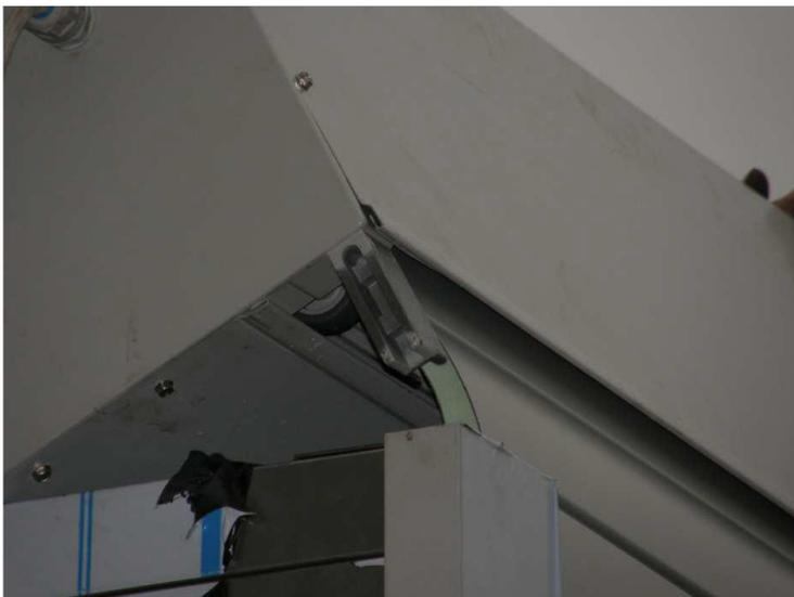
3. Les supports latéraux doivent être insérés dans les logements. Le caisson de volet roulant est alors bien fixé sur l'EWK.
