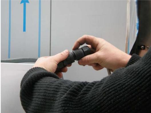
c. und dann die fertig verschraubte, komplette Steckverbindung an die Halterung stecken.
