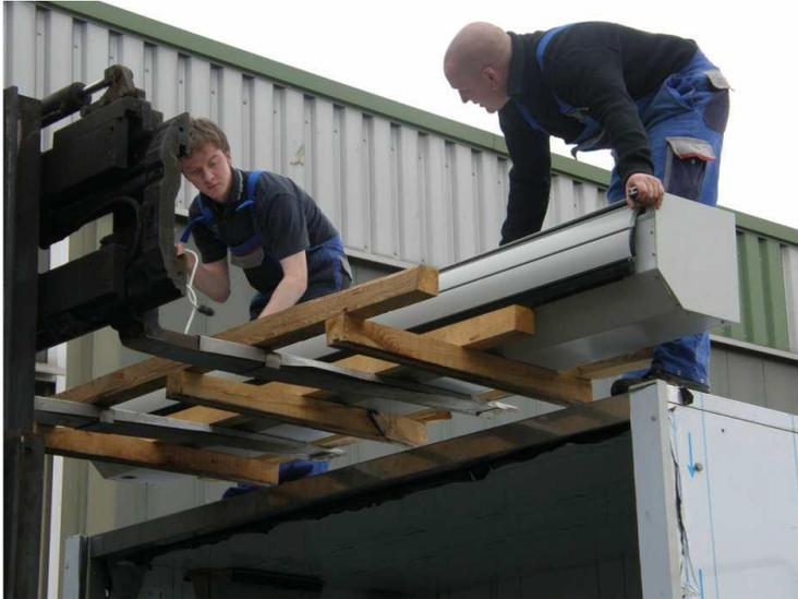
2. Nun müssen die Rollladenlamellen in die seitlichen Führungsschienen des EWK eingeführt werden. Dazu kippt man den Rollladenkasten vorsichtig um ca. 80° und führt die Rollladenlamellen in die Führungsschienen ein.
