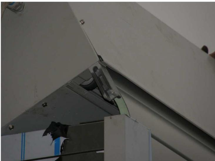
3. Die seitlichen Halterungen müssen in die Aufnahmen gesteckt werden. Dann liegt der Rollladenkasten sicher fixiert auf dem EWK.
